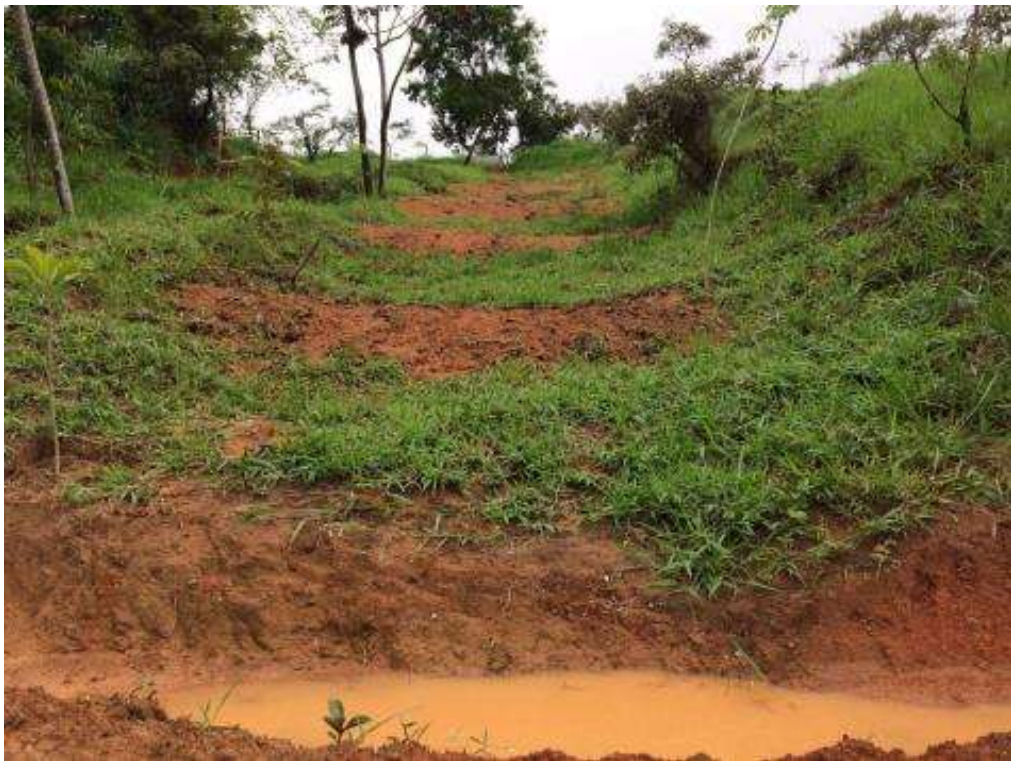
Figura 41 - Swales para a contenção do fluxo de enxurrada que desce da nascente Fonte: Gos Florestal, dezembro 2016
