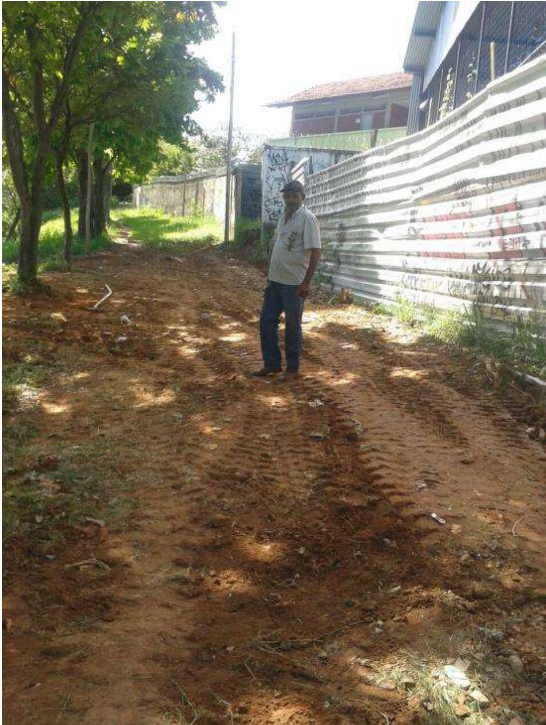
Figura 51 - Nascente após a retirada dos entulhos. Fonte: Gos Florestal, dezembro 2016
