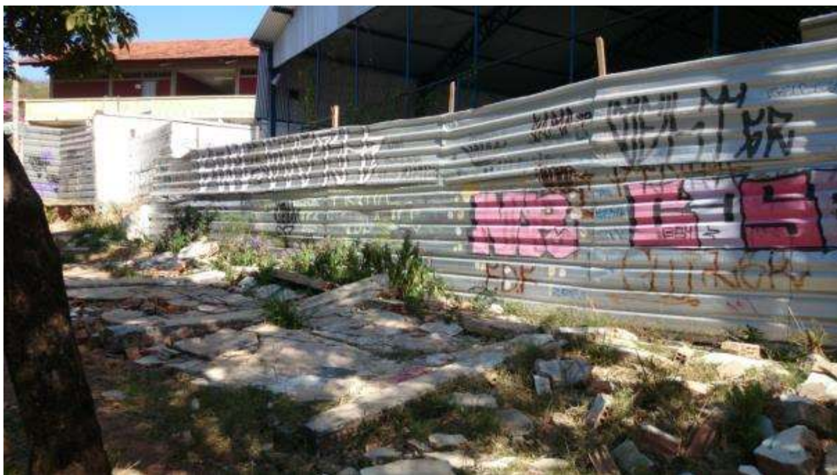
Figura 46 - Nascente Parque do Planalto antes da intervenção Fonte: Gos Florestal, novembro 2016
