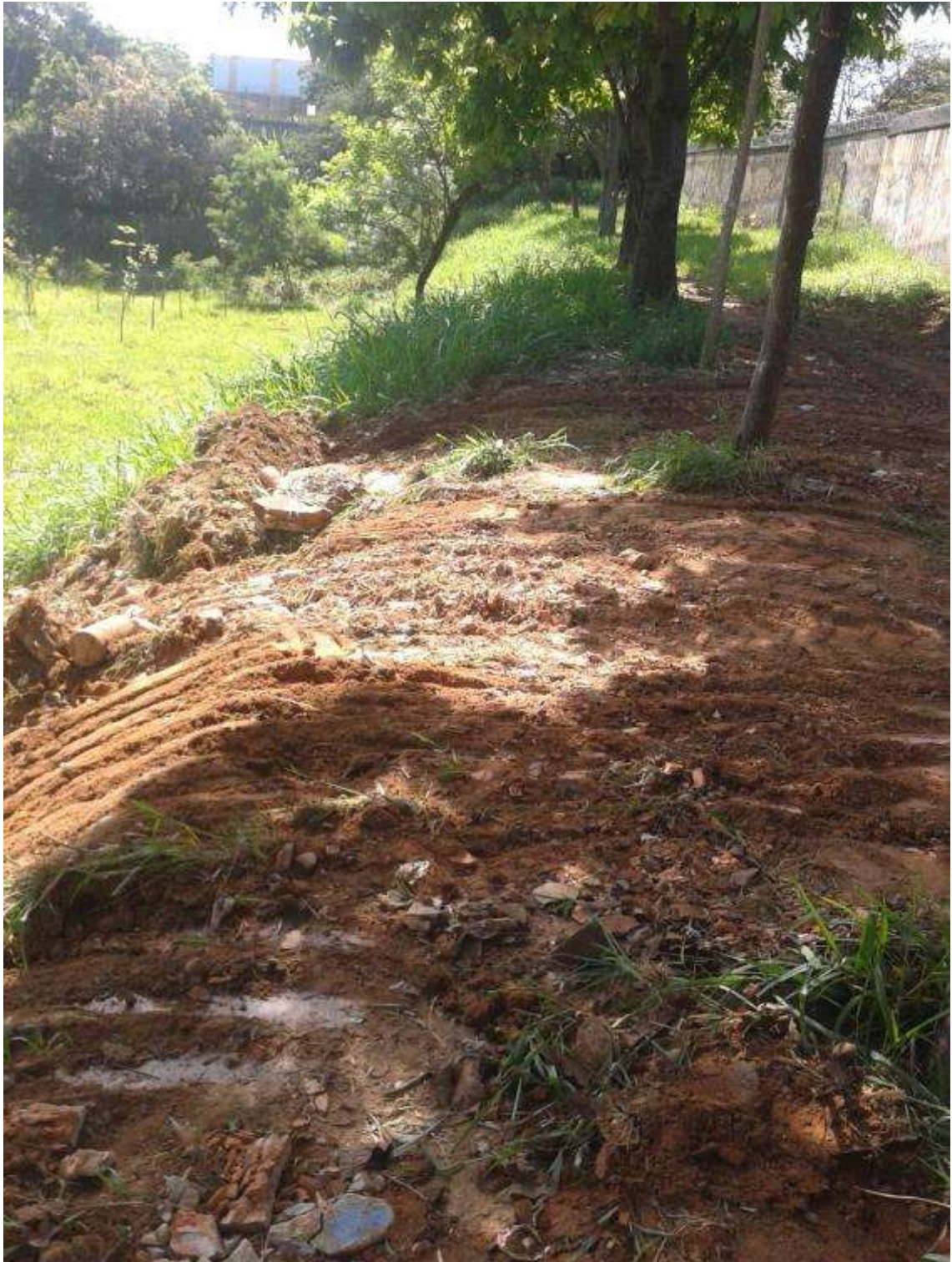
Figura 50 - Vista da área após a retirada dos entulhos Fonte: Gos Florestal, dezembro 2016
