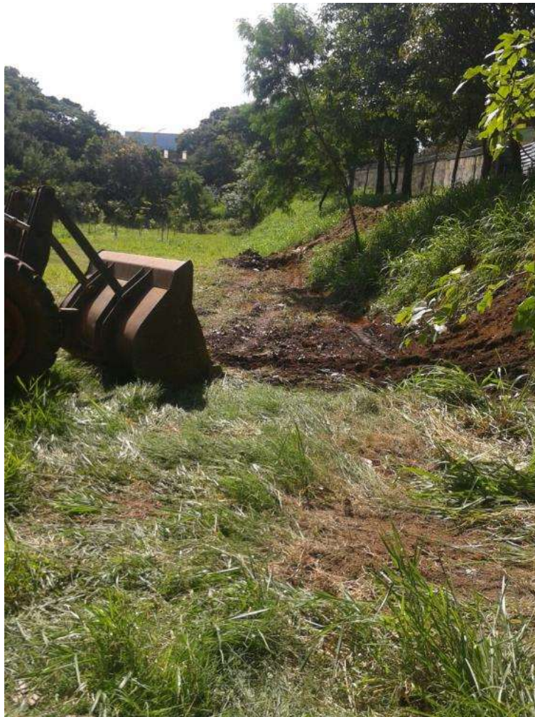
Figura 18 - Vista da área durante a retirada dos entulhos. Fonte: Gos Florestal, dezembro 2016
