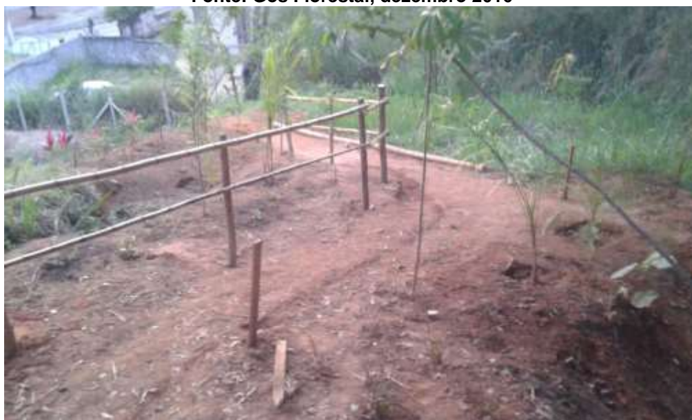
Figura 17 - Obras de melhoria do acesso até a nascente.
