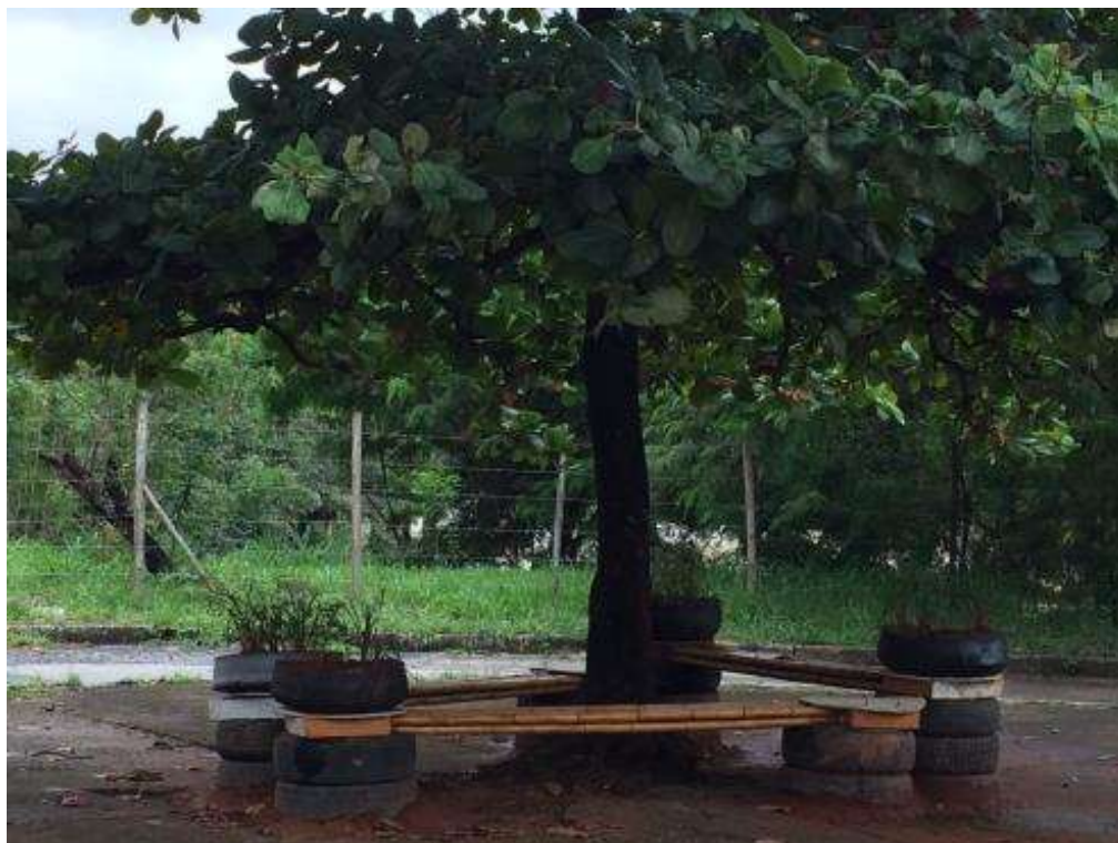
Figura 44 - Bancos em bambu tratado construídos durante a Oficina de construções em bambu Fonte: Gos Florestal, dezembro 2016
