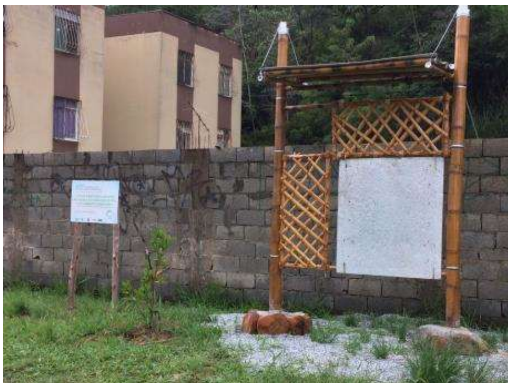
Figura 39 - Pórtico em bambu tratado pelos alunos da Oficina de Capacitação em Construções em Bambu
