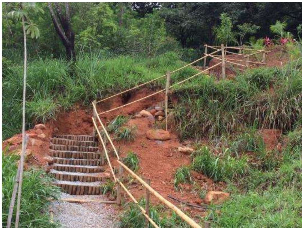
Figura 38 - Escada em eucalipto tratado e piso drenante com corrimão de bambu
