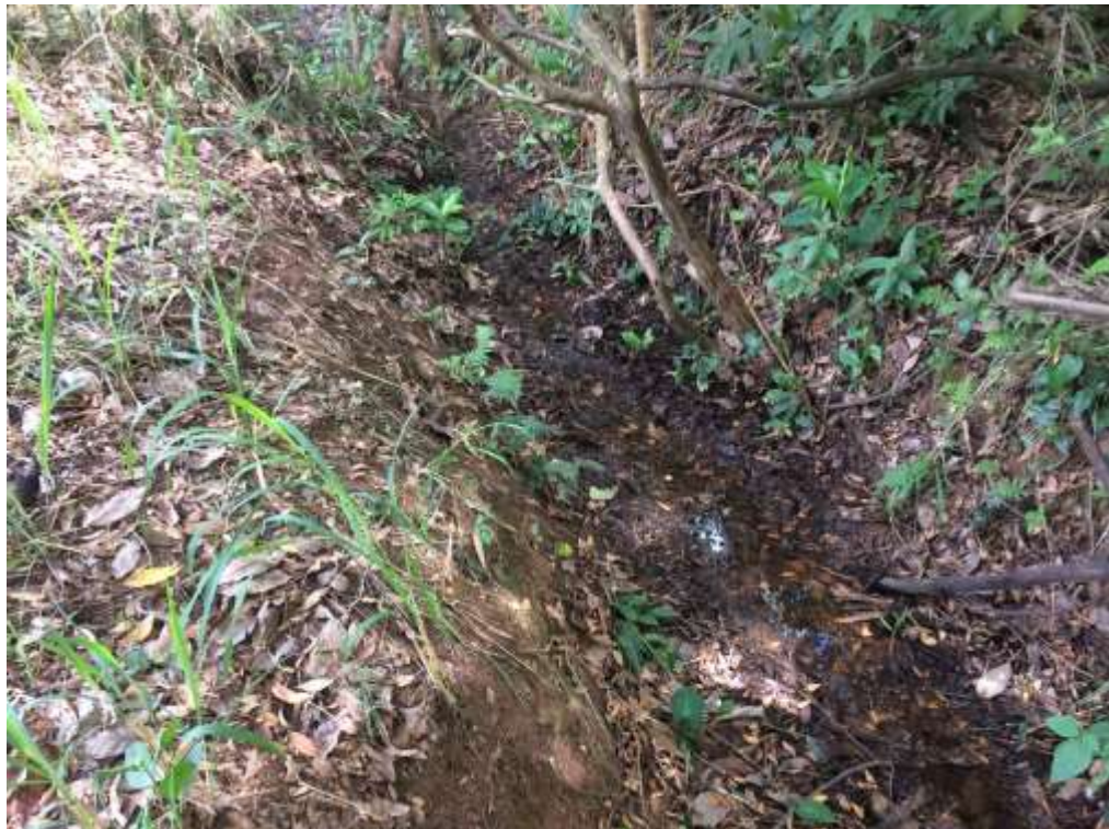
Figura 22 - Canaleta depois da limpeza. Fonte: Gos Florestal, dezembro 2016
