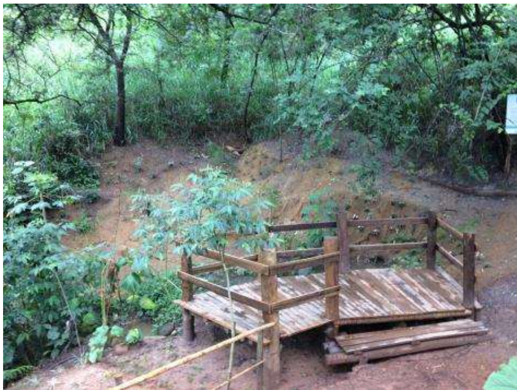
Figura 42 - Deck em eucalipto tratado construído próximo à nascente para evitar o pisoteio e biomanta instalada para conter os processos erosivos no entorno da nascente
