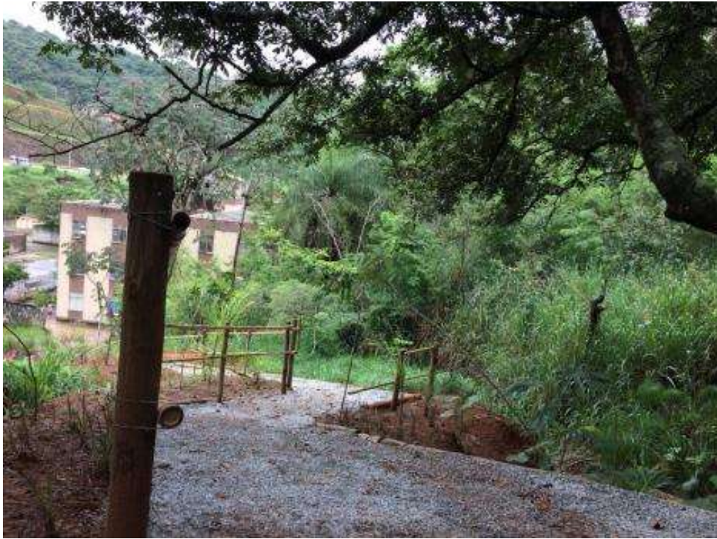
Figura 40 - Passarela em piso drenante e corrimão em bambu tratado pelos alunos da Oficina de Capacitação em Construções em Bambu Fonte: Gos Florestal, dezembro 2016
