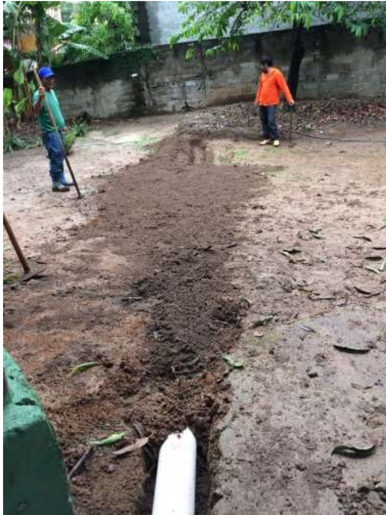
Figura 11 - Construção de drenos para direcionamento do fluxo das águas das chuvas e swales para contenção das enxurradas Fonte: Gos Florestal, dezembro 2016
