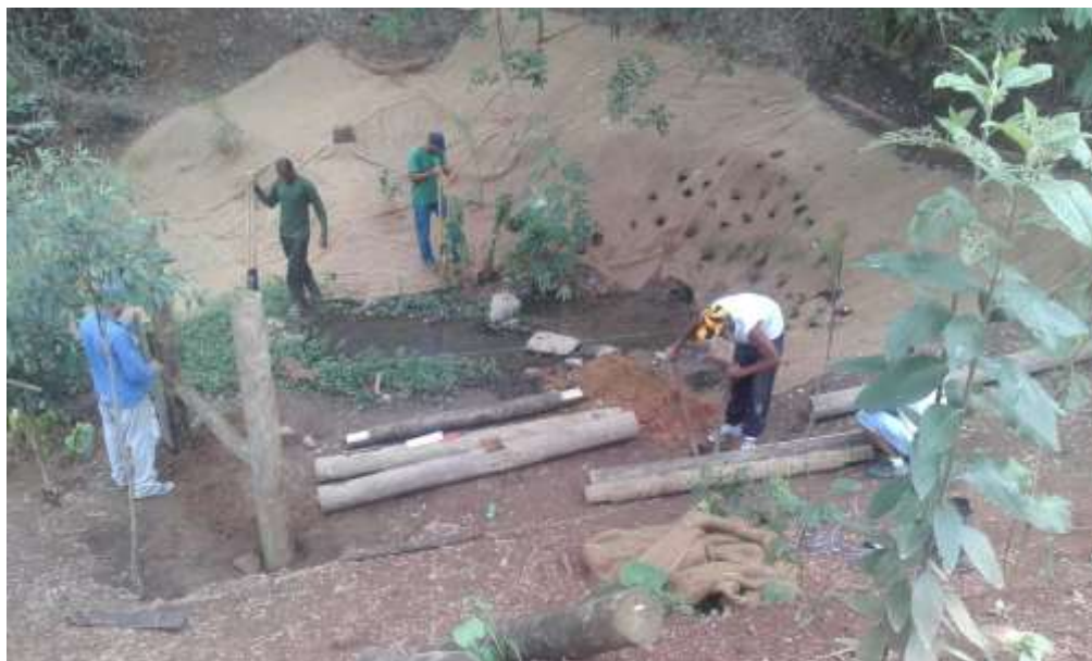
Figura 16 - Construção do deck em madeira de eucalipto tratado e plantio de espécies ornamentais no entorno da nascente.
