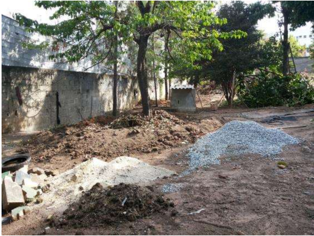
Figura 27 - Materiais para as obras, novembro 2016 Fonte: Gos Florestal
